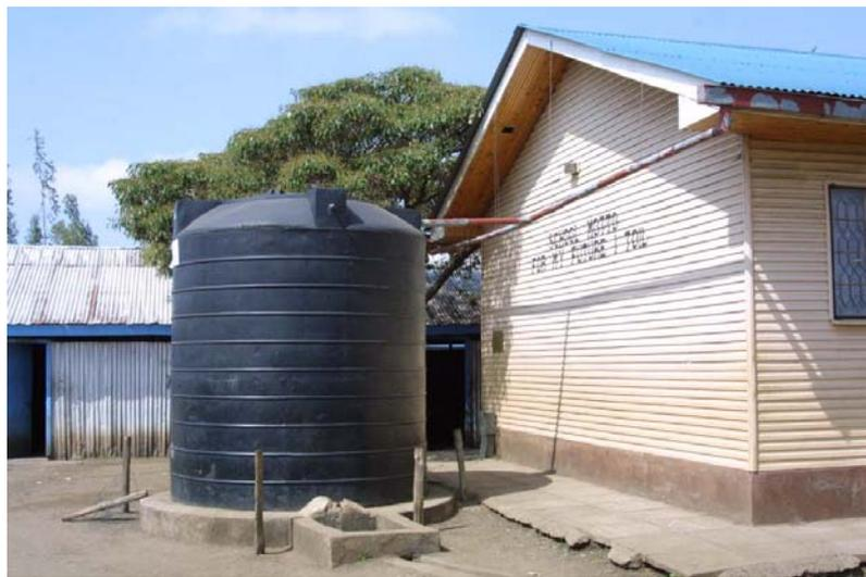
Abb. 36 u. 37: Der kaputte Ablaufhahn für die Wasserbehälter waren schon einige Jahre kaputt. Das kostbare Dachwasser versickert jetzt im Boden. Fotos: Kerndler (2004).
