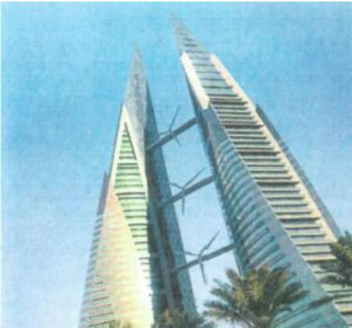
**Abb 10.** World Trade Center in Bahrain mit drei Windrotoren mit 29 m Rotordurchmesser und je 225 kW Nennleistung (Hau, 2016, S. 81)
