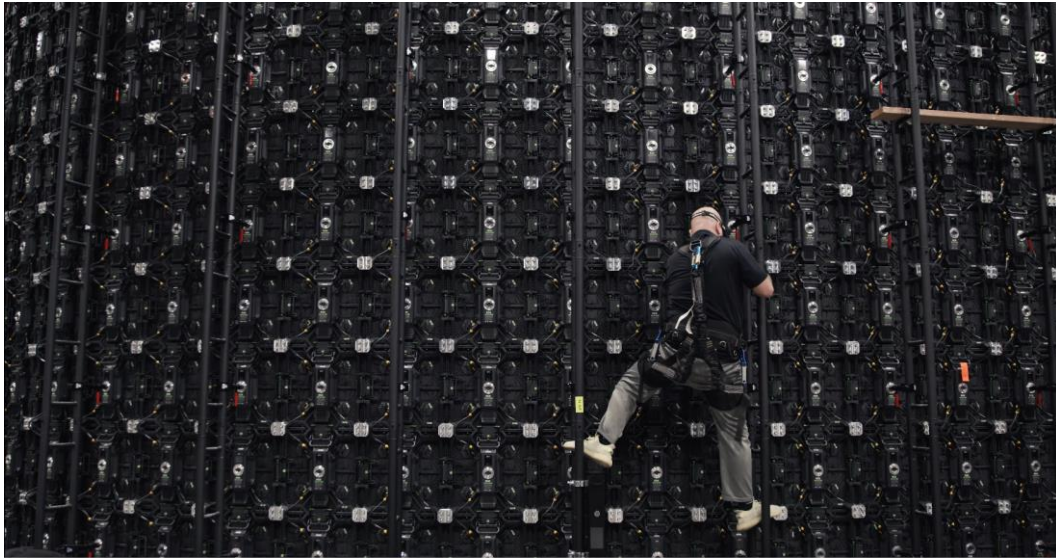
Abbildung 10 – Rückseite einer LED-Wand inkl. Leitern
